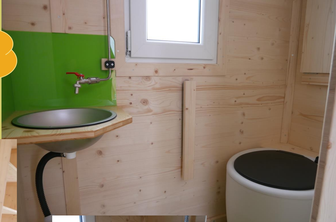
Komposttoilette und Waschbecken ohne Wasseranschluss
